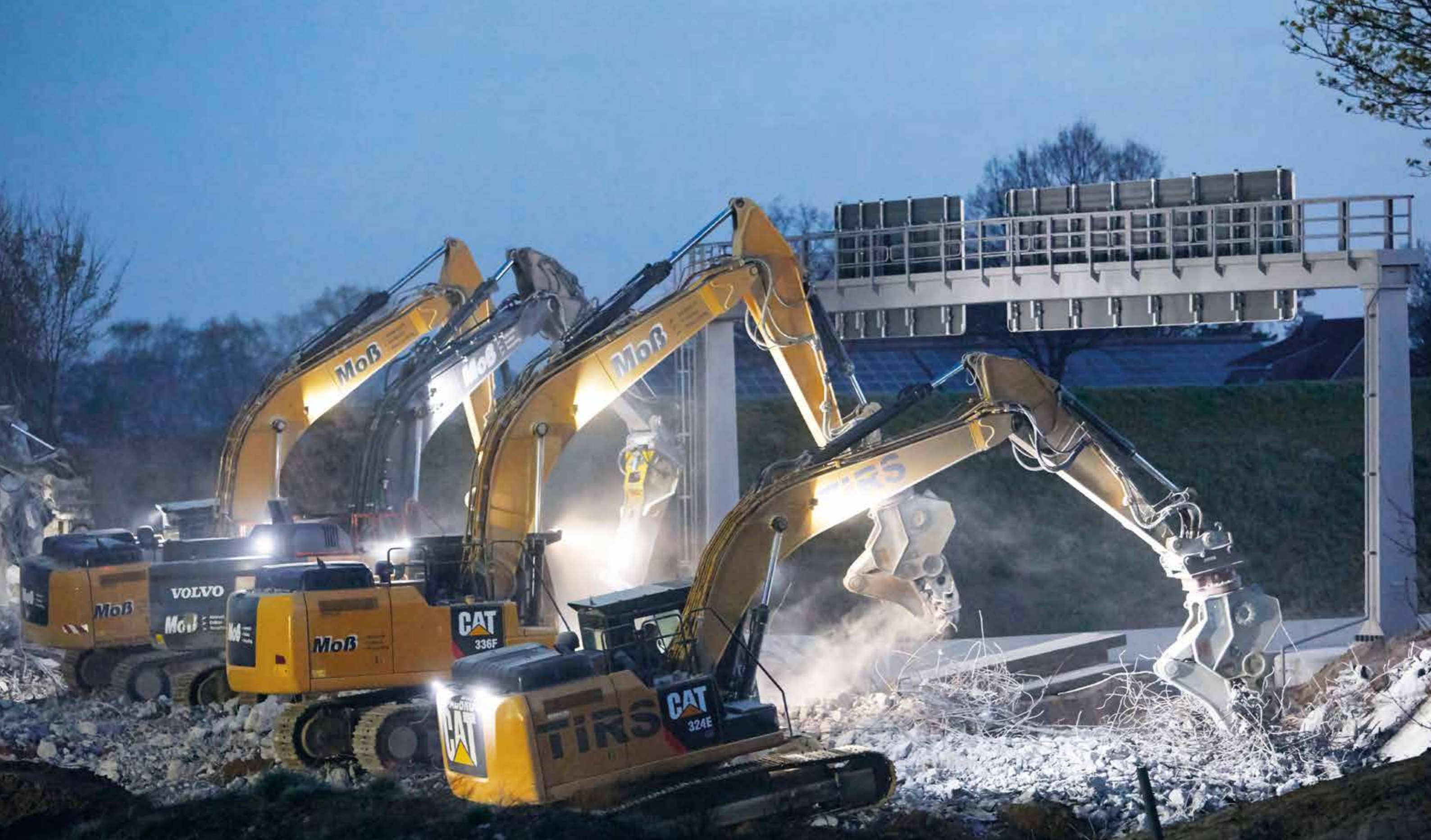
Voller Einsatz: Brückenabbrucharbeiten bei Kaltenkirchen
